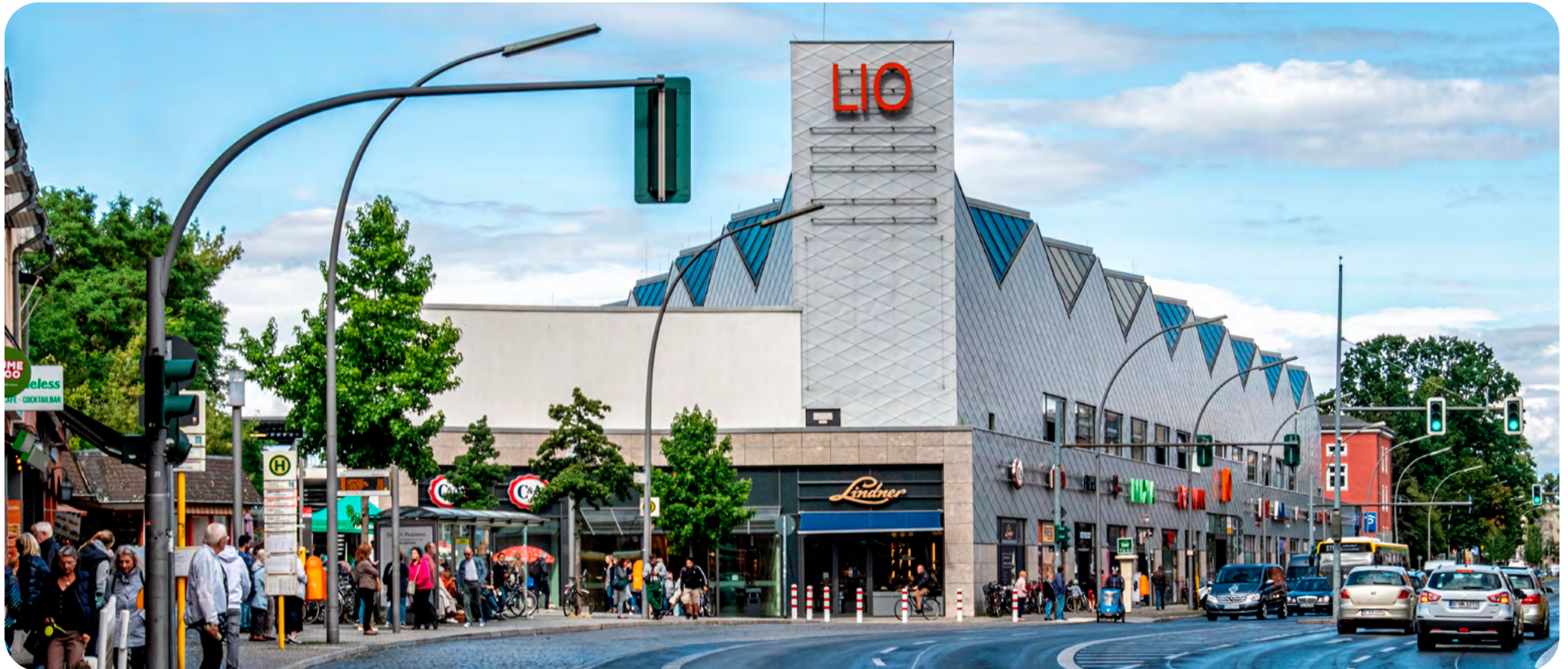
El aparcamiento del centro comercial Lio (Berlín), de 308 plazas, amplía la presencia de Saba en Alemania.
