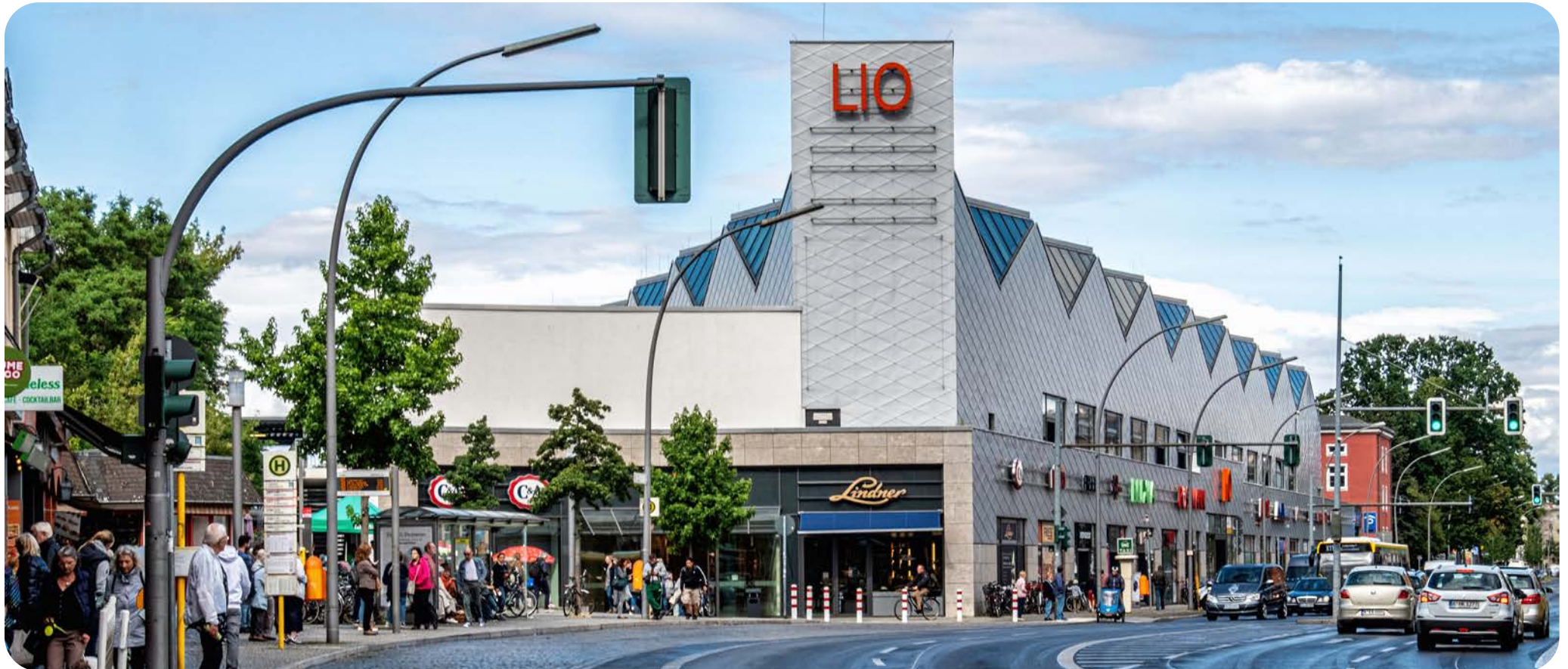
El aparcamiento del centro comercial Lio (Berlín), de 308 plazas, amplía la presencia de Saba en Alemania.
