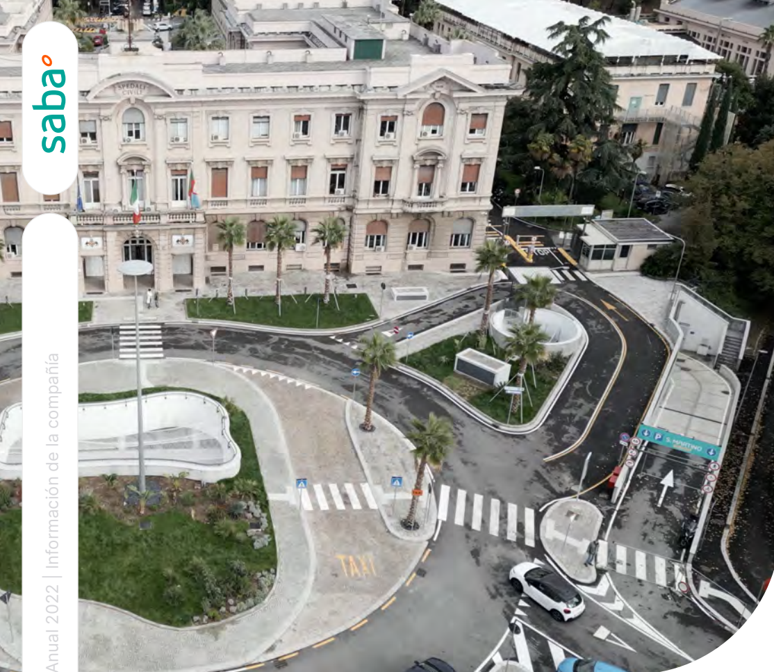
Imatge exterior de l'aparcament Saba Ospedale San Martino, inaugurat a la ciutat italiana de Gènova.
