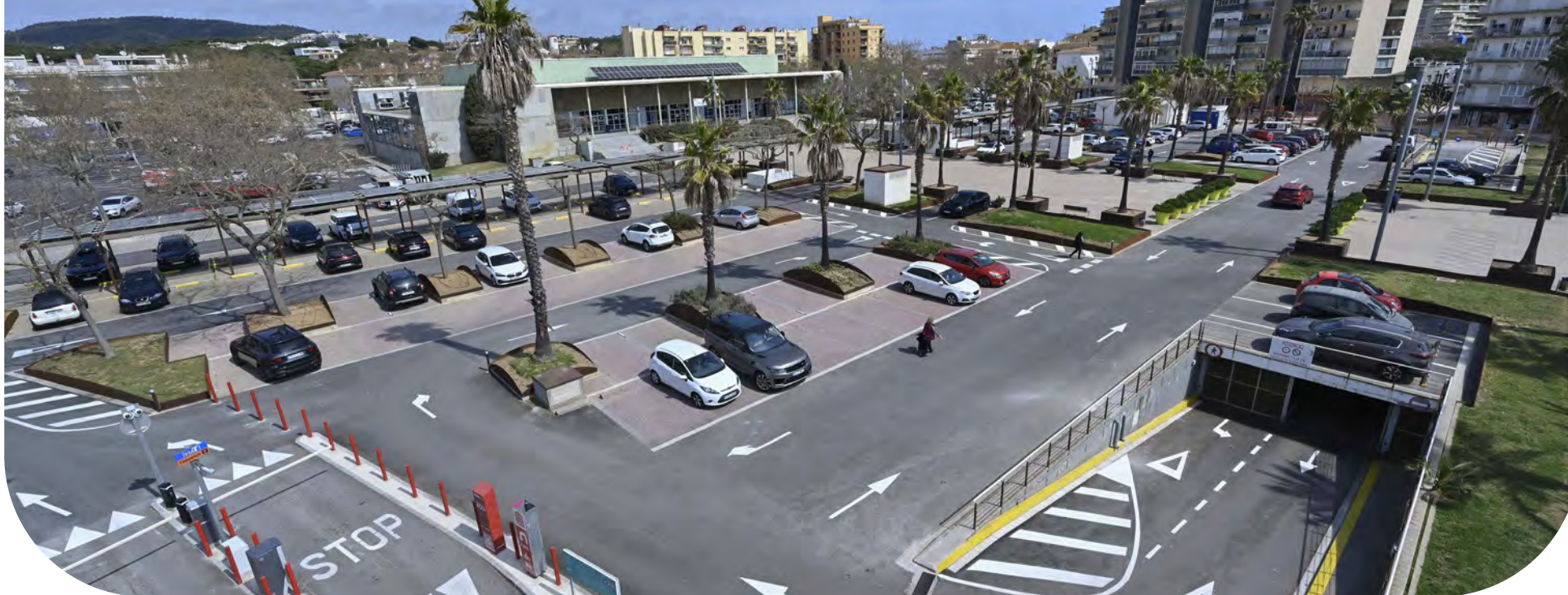
Plànol general de l'aparcament de Saba Plaça d'Europa (Platja d'Aro), primera infraestructura de la companyia desenvolupada amb una òptica autosuficient en termes energètics.
