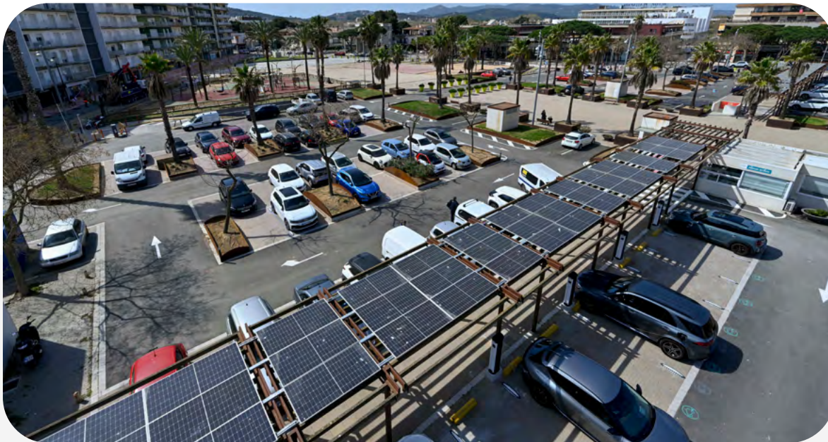
Photovoltaic canopies at Saba Hospital de Sant Pau (Barcelona) and Saba Pl. d'Europa, Platja d'Aro (Girona).
